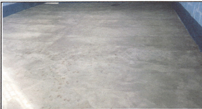
Foto 1: finalizacion del mejoramiento total del piso de una de las aulas con el apoyo del programa de mantenimiento de edificios escolares publicos y la mano de obra de padres de familia.
