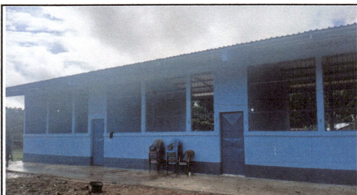
Foto 3: Vista frontal de las paredes de las aulas remozadas con mano de obra de padres de familia no calificada con fondos del Progama de mantenimiento de Edificios Escolars Publicos.
